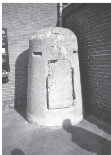
Fig. 13 et 14 - Un des abris de chemin de fer du "Remember Museum". L'ouverture de la porte permet de voir en partie l'orifice d'évacuation, obturé par des briques. La banquette transversale a disparu (© Claude Gaier).
