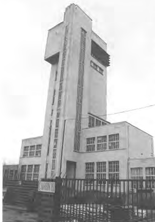
Fig. 9. Ressaix – Siège St-Albert : la tour d'extraction du puits 1 (1954).
