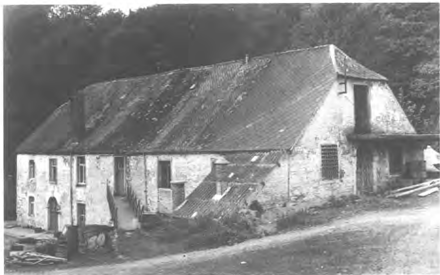
Le bâtiment de la fenderie de Poix en 1944 (photo ACL-IRPA)
