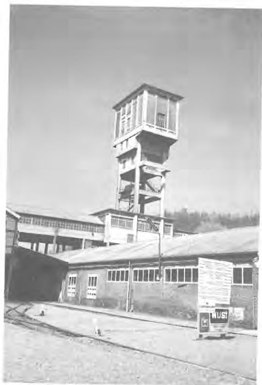
Fig. 6. Argenteau – Siège de Blégny : la tour d'extraction du puits 1 (1945)
