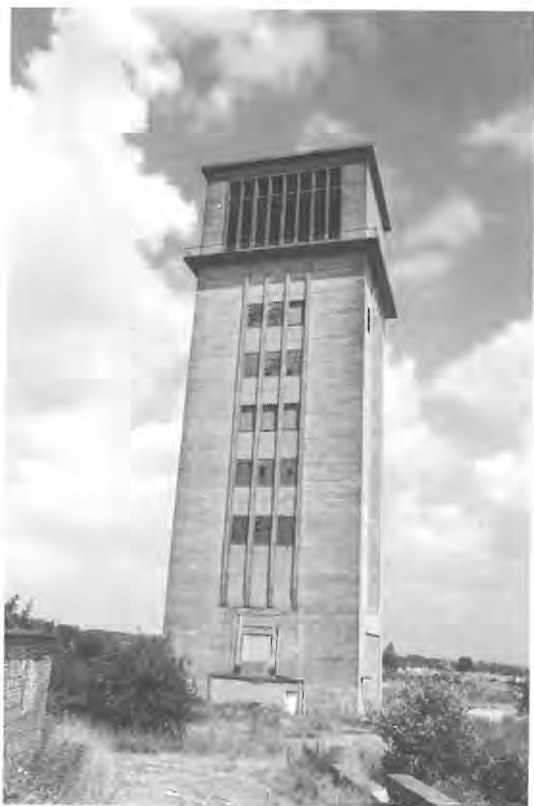
Fig. 10. Farciennes – Siège du Roton-Ste-Catherine : la tour d'extraction du puits n°5 (1960).
