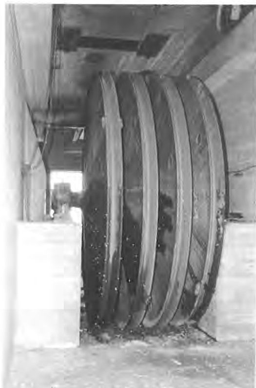
Fig. 12. Farciennes – Puits n°5 du Roton-Ste-Catherine : poulies de recentrage des câbles d'extraction.
