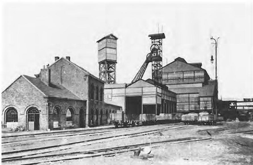
Fig. 3. Montegnée – Siège St-Nicolas : de gauche à droite, la tour du puits d'air, le puits d'extraction et le triage lavoir.
