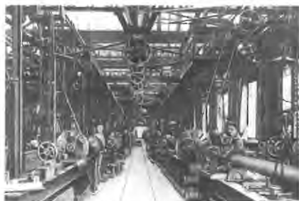
Usine Thyry à Huy. Vue intérieure d'un atelier de tournage (longueur 130 mètres) vers 1900.
