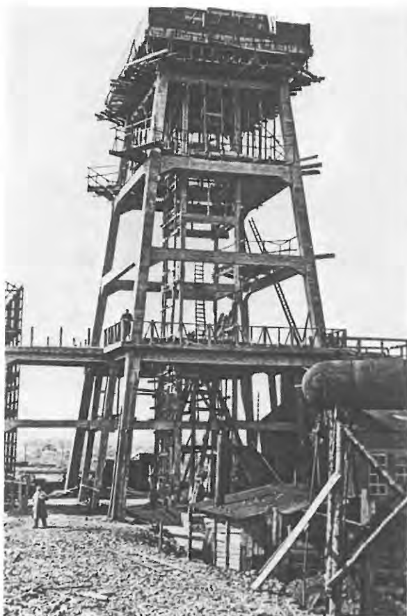
Fig. 3. Argenteau – Siège de Blégny : la tour en construction (1925).
