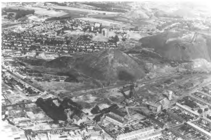
Rouvroy-Drocourt. Fosse 2 de Drocourt et cités Darcy et Promper (1973)
