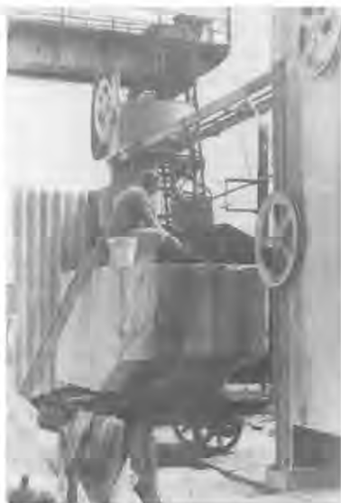
Maffle. Découpage d'un bloc au fil hélicoïdal au chantier Gain-Bougard en 1976.
