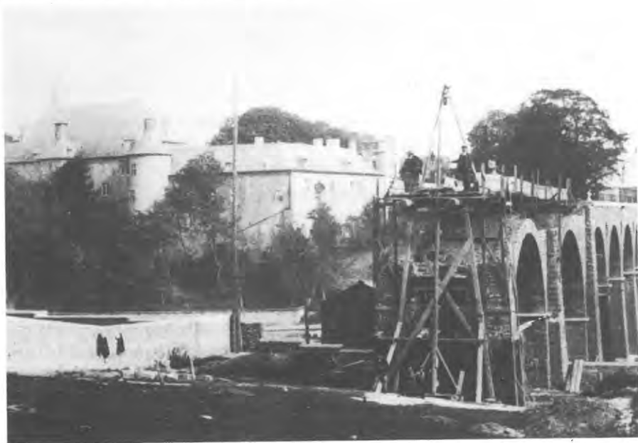
Viaduc d'Ecaussinnes-Lalaing en construction (un peu avant la Première Guerre Mondiale).
