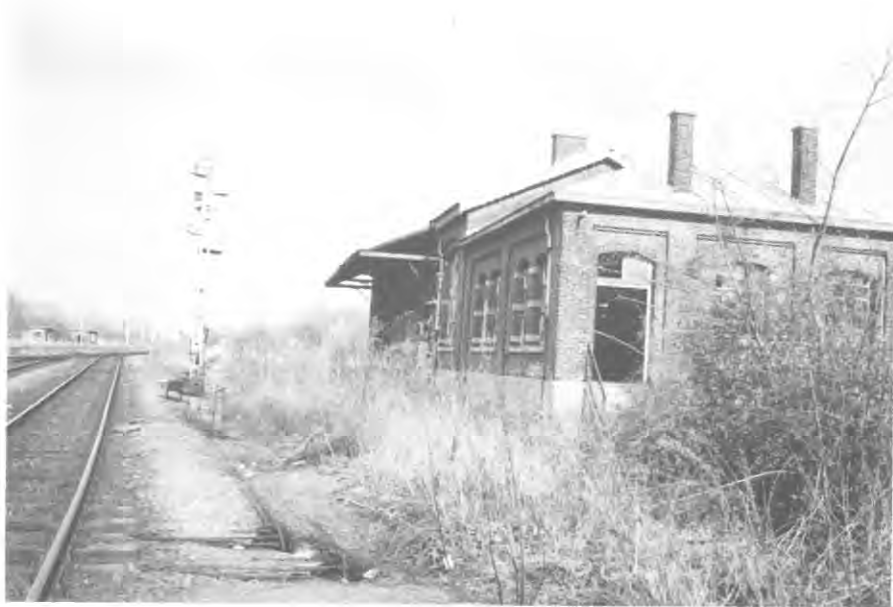
Quiévrain, gare S.N.C.B. - Hangar à marchandises.
