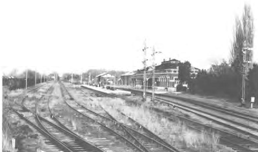
Quiévrain, gare S.N.C.B. - Vue générale du site.
