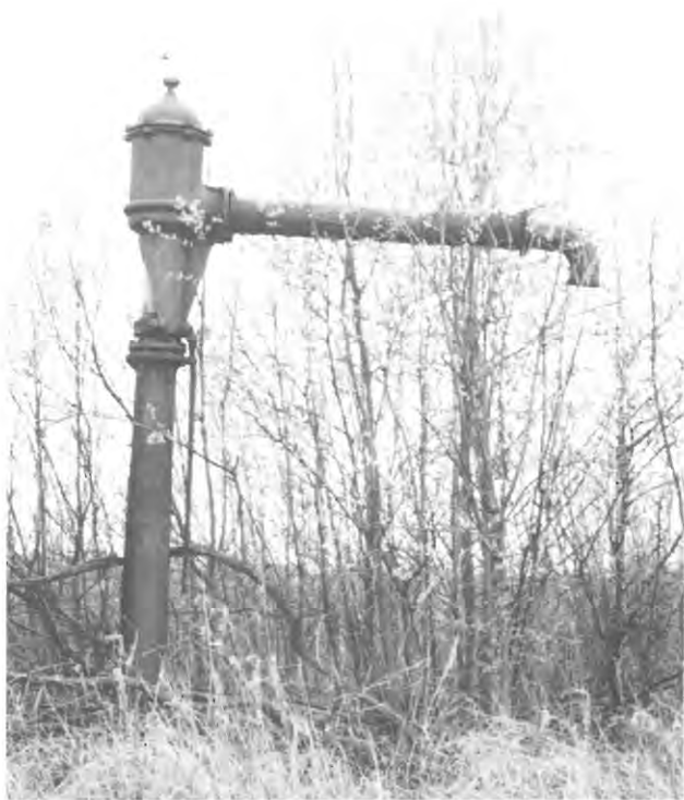
Pompe d'alimentation des locomotives.
