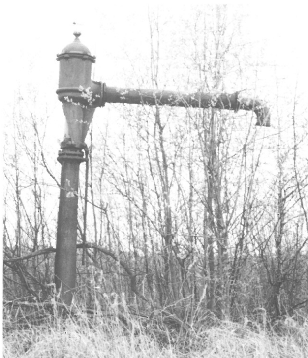
Pompe d'alimentation des locomotives.
