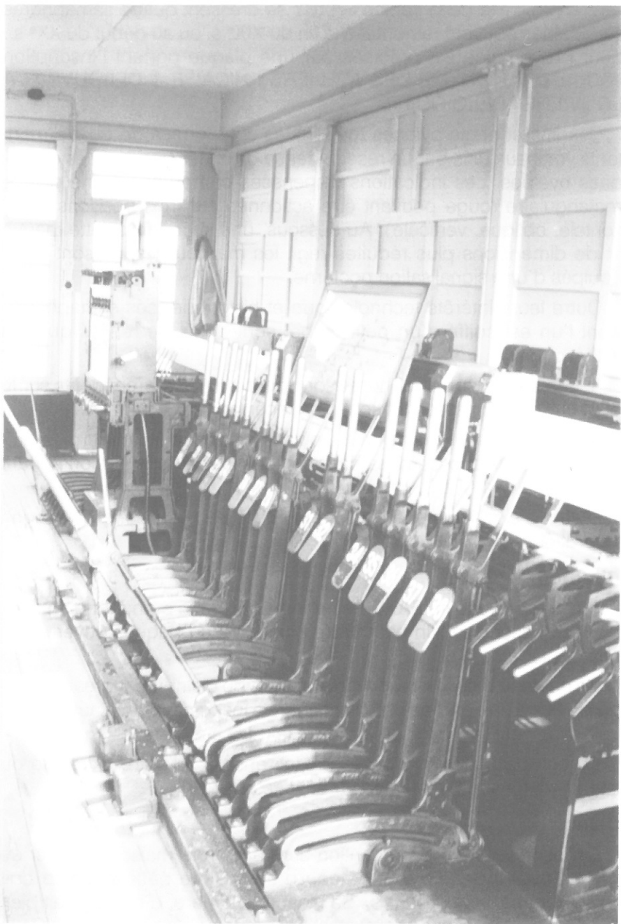
Quiévrain, gare S.N.C.B. - Cabine de commande de type SAXBY.
