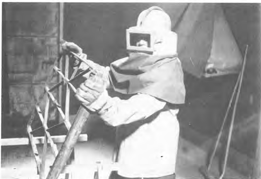
Restauration des grilles en fer forgé.
