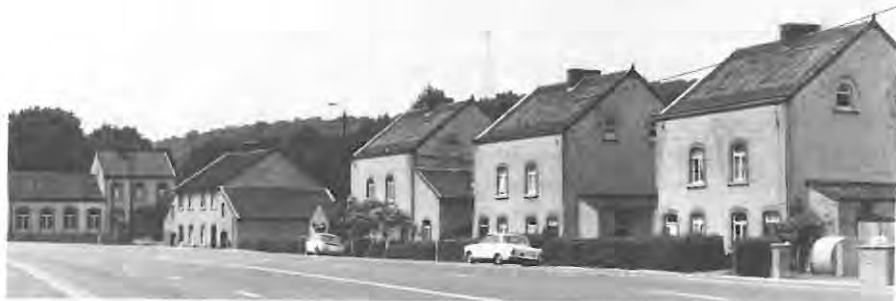
Fig. 4: Fraction de la Cité de la Villette. Au fond, les écoles. Etat en 1975.
