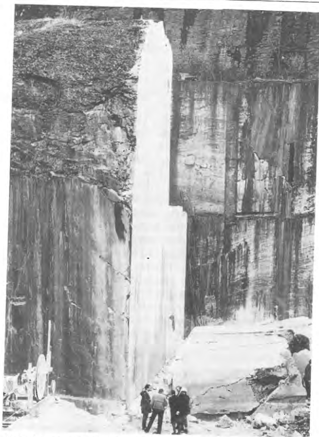
Neuville. Carrière de marbres rouges et brès. Abattage d'une masse de pierre (1987).
