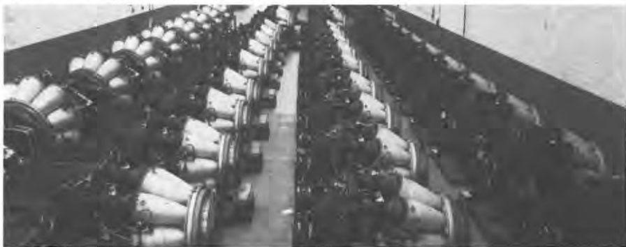
Production à la FN du turboréacteur Rolls-Royce Derwent MK8 équipant le Gloster Meteor, premier chasseur à réaction de la Force Aérienne Belge (1954).
