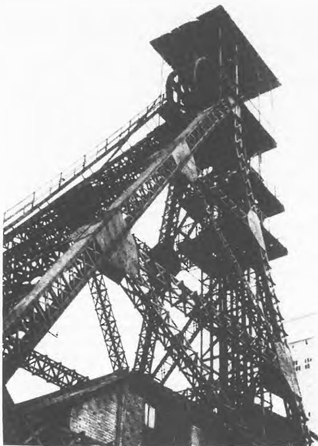
Chevalement du Bois-du-Casier (Marcinelle).
