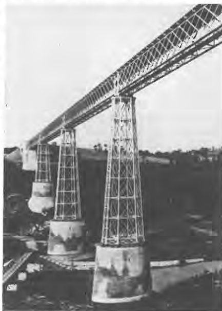
Le viaduc de la Cère sur la ligne Figeac-Aurillac.
