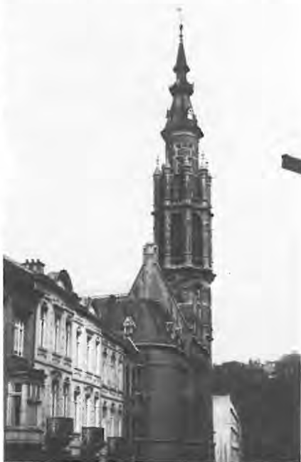
Grand' Poste de Verviers.
