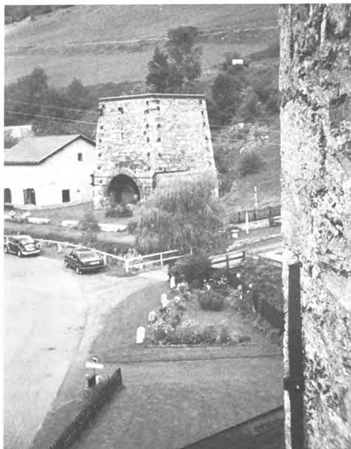
Ancien haut- fourneau de Vordernberg (19 e siècle)
