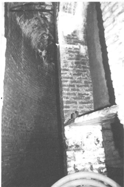
Glacière de l'Abattoir (Spa) Couloir circulaire autour de la glacière. Ce couloir est muni de logettes desti- nées à recevoir les quartiers de viande.
