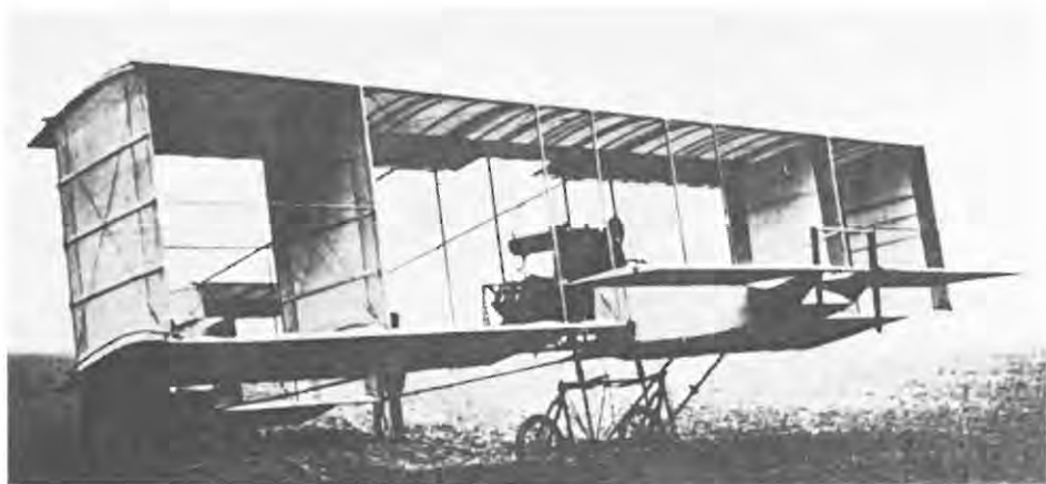
Fig. 2. L'avion Voisin de 1909 -modèle civil- est un ensemble de solutions techniques au problème du vol. Cet appareil procède d'une conception fondamentalement différentes de celle qui fut à l'origine de l'Avion d'Ader.
