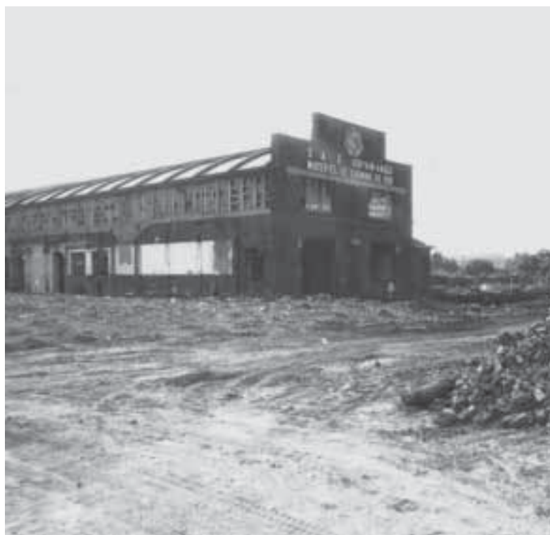
Quelques mois après le début des travaux d’assainissement, seuls quelques bâtiments subsistent encore. Photo anonyme, 1970 (collection Ecomusée régional du Centre).
