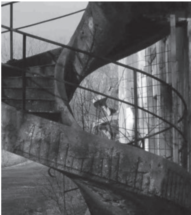
Les escaliers à vis en béton.
