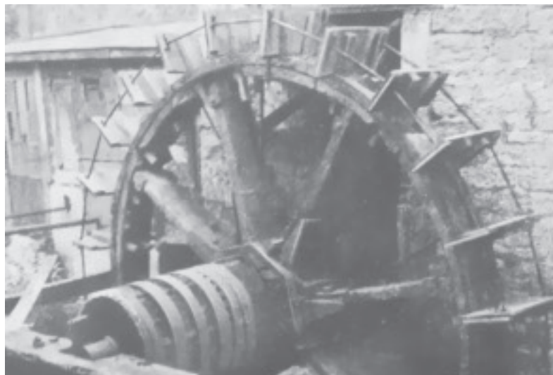
Roue hydraulique à l'ancien "maka" (marteau) de Chaudfontaine (18 e siècle)(cliché Musée d'Armes de Liège)
