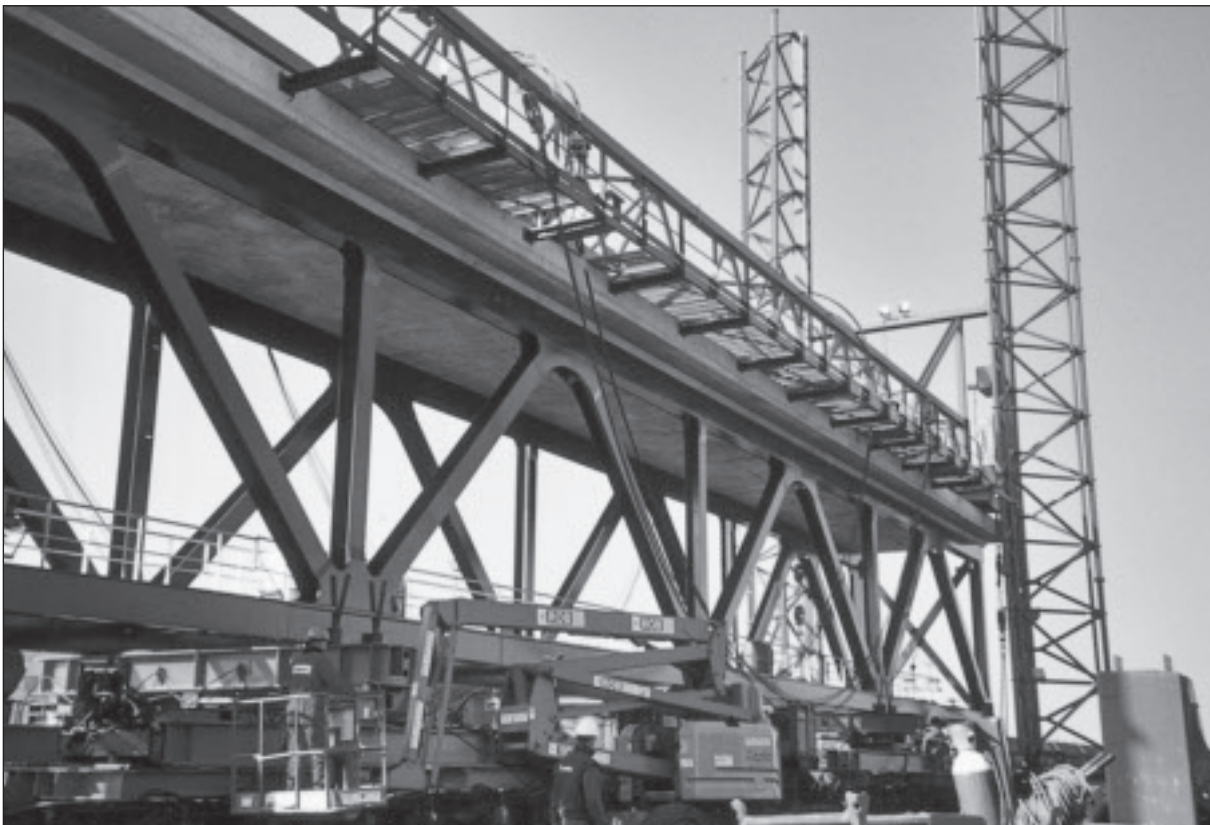
Fig. 14 - Nouveau tablier et ses vérins prêts au transport (© Jean Defer).
