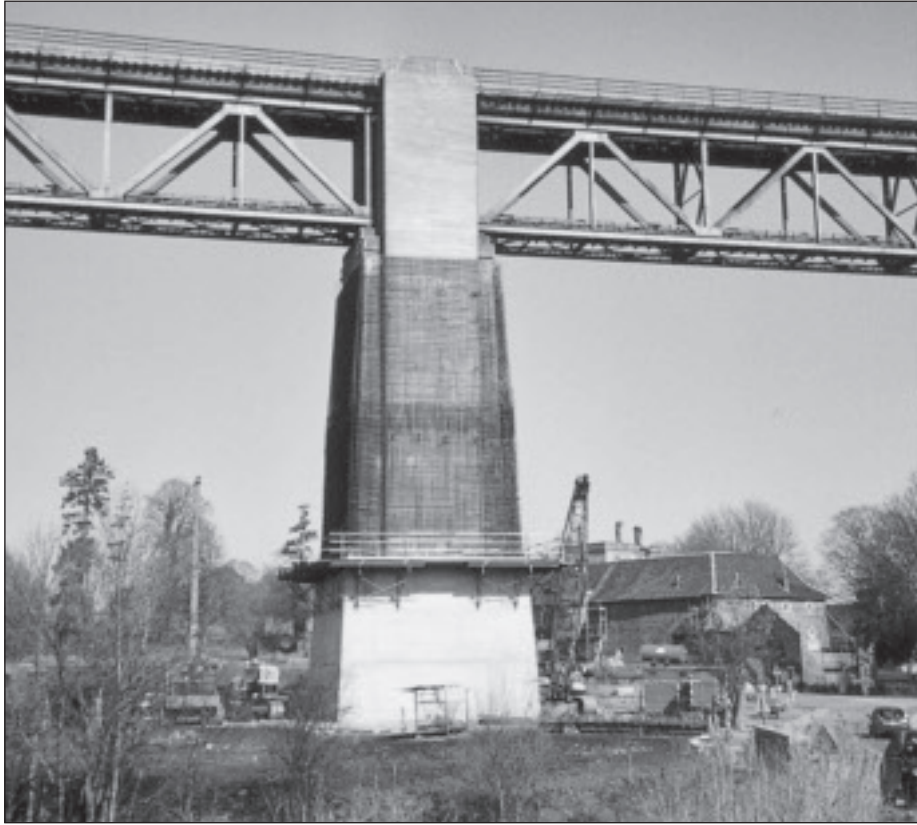
Fig. 13 - Une pile en réfection (© Jean Defer).
