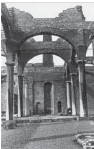
Fig. 5. - Anciens ateliers, vers 1994 (©Collection SAICOM, photo Vincent Vincke).
