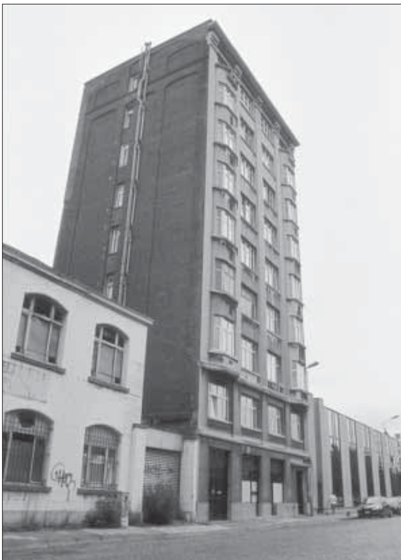
Un ancien silo des "Meuneries Bruxelloises" (1907), situé près de la gare du Nord, est un des rares exemples de reconversion d'un bâtiment industriel en logements avant 1940. Il s'agit d'une transformation en seize logements réalisées par l'architecte R. VERDEUREN en 1935. ©P. VIAENE.
