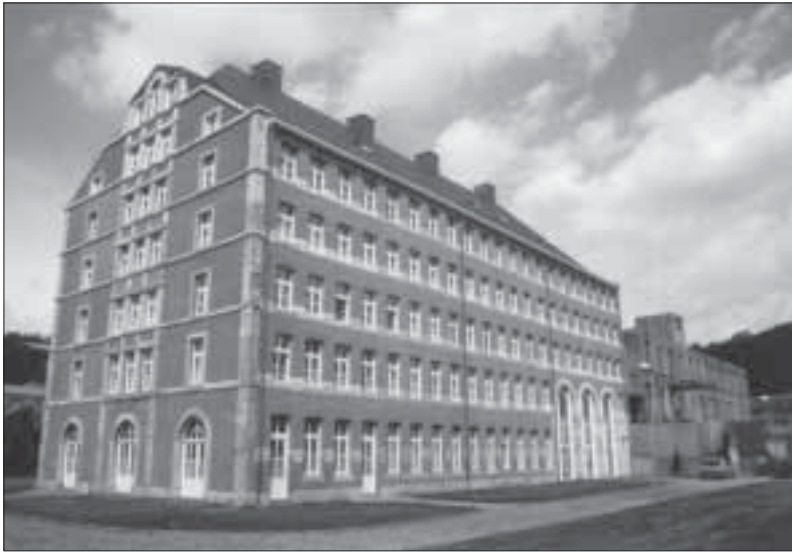
Un bâtiment-phare à Verviers : la filature "Le Chat" du fabricant Simonis, reconvertie en logements sociaux par la Ville au milieu des années 1980. ©P. VIAENE.
