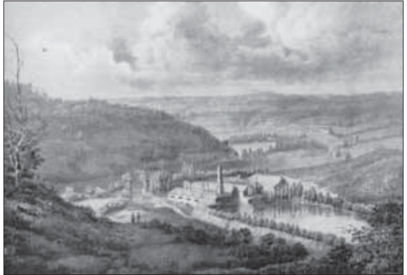
Vue d'ensemble des installations à Pernelle.
