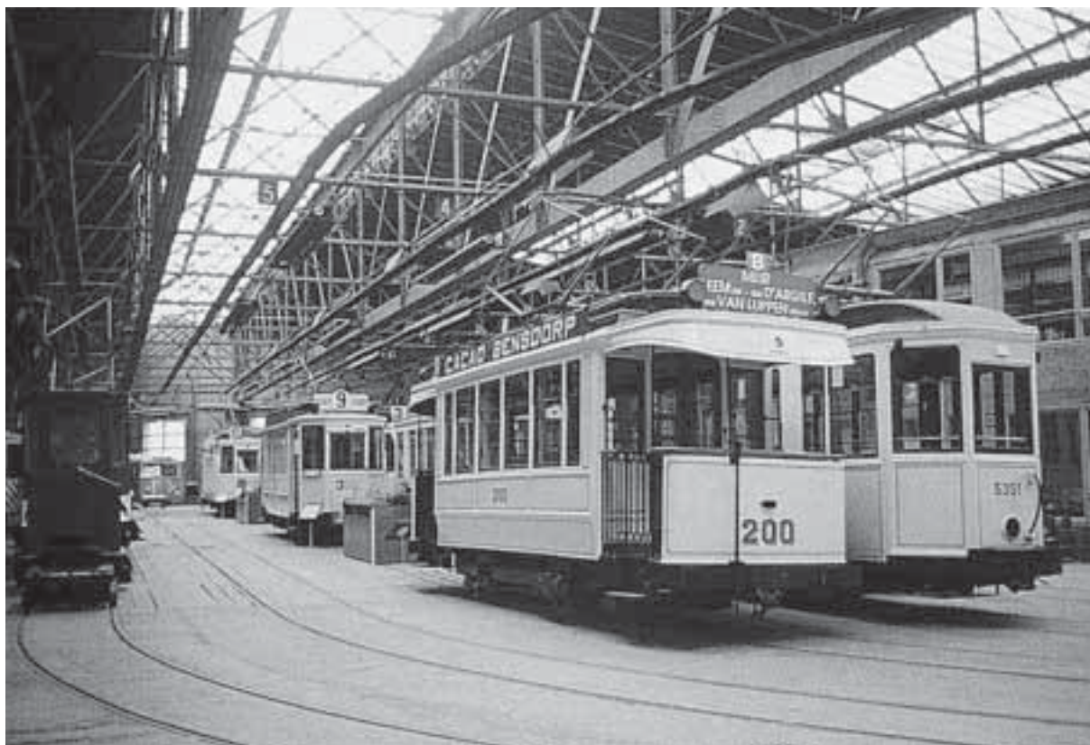
Une vue de l'entrepôt du VTA.
